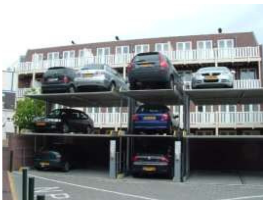
شکل ۶- سامانه پازلی طبقاتی با حرکت عمودی - افقی
