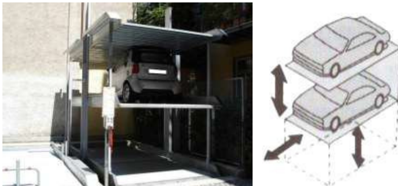
شکل ۱- سامانه با ظرفیت دو یا سه خودرو با حرکت عمودی
